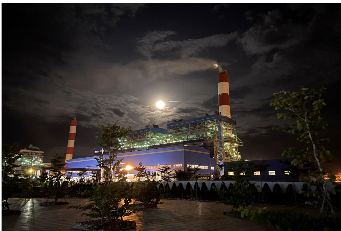
Hình 4.1 Nhà máy Nhiệt điện Vĩnh Tân 2
