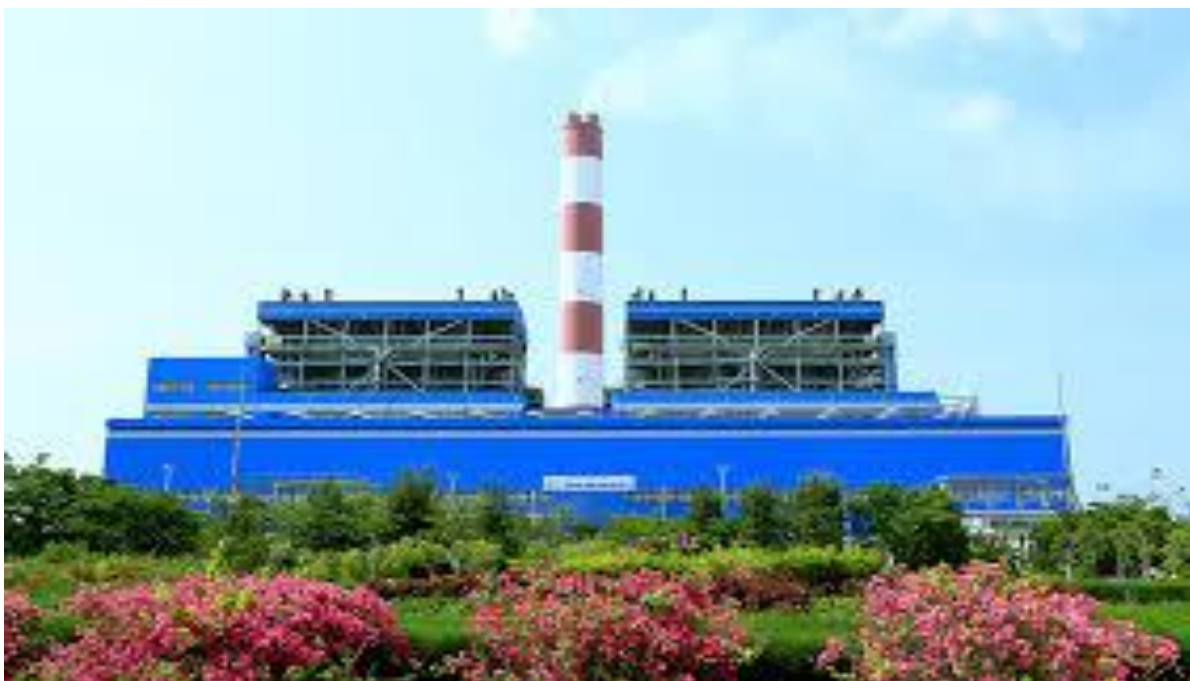
Hình 2.1: Nhà máy Nhiệt điện Vĩnh Tân 2
